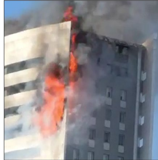
Figura 36: fotogramma a 27 secondi dall'inizio del filmato: le fiamme su retro della vela hanno raggiunto il 19° piano prima di quelle sul fronte verso strada
